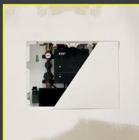
// Intégration dans le support en placoplâtre dans la cloison sèche
