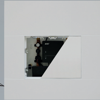
Nahezu unsichtbar Unterputz // Einbindung im Fliesenspiegel
