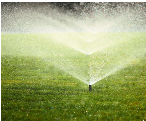
Beispiel: Bewässerung mit hohem Volumenstrom (5,8 m³/h)
