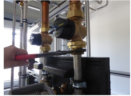
Anschlussverschraubung lösen
