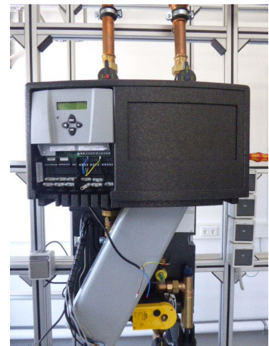
Regler in Dämmhaube einsetzen und verdrahten
