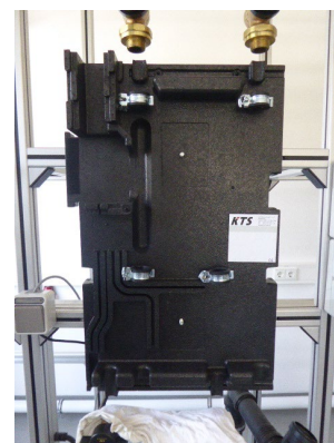
Schellen bis zur Dämmung schrauben
