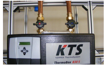
Absperrung der Heizungsseite
