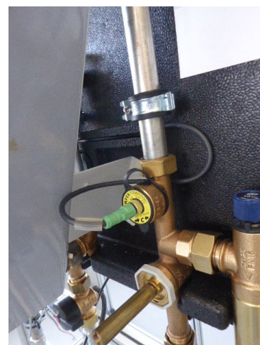
Anschlussstecker wieder aufschrauben
