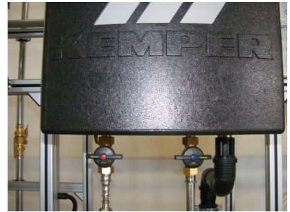
Absperrung der Wasserseite
