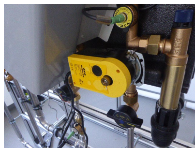
Stellmotor mit 4-er Inbusschraube befestigen. Sicherheitsventil-Tropfleitung anschließen
