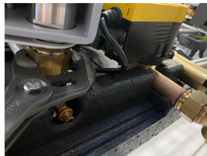
Anschlussverschraubung lösen
