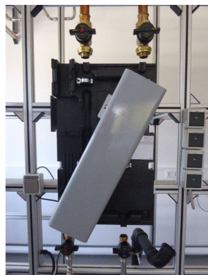
PWÜ mit 2 neuen M8 Muttern und U-Scheiben befestigen
