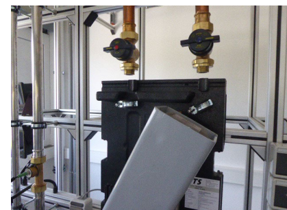
Obere Anschlussleitungen demontiert
