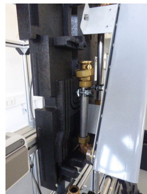
Neue Dichtungen in die Verschraubungen einlegen
