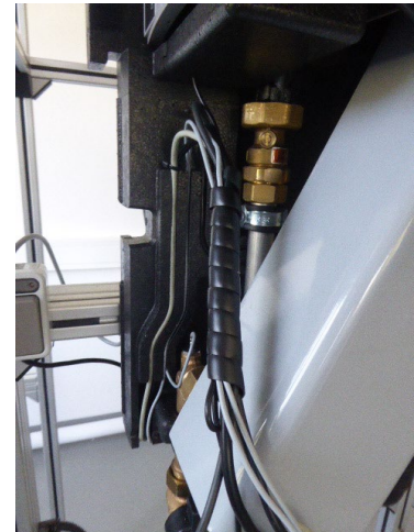
Kabel mit Spiralschlauch bündeln
