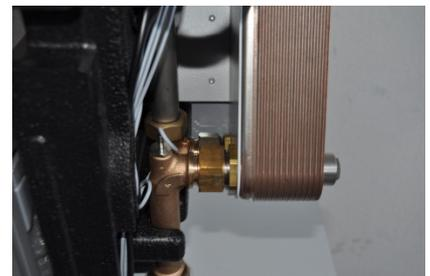
Bild 13 - untere Verschraubung PWÜ
