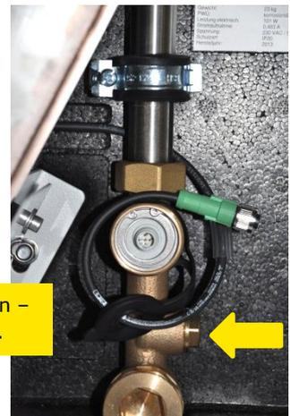
Bild 17 - Volumenstromsensor
