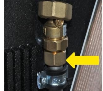
Bild 12 - Schwerkraftbremse
