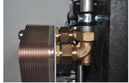
Bild 14 - obere Verschraubung und Kontermuttern PWÜ
