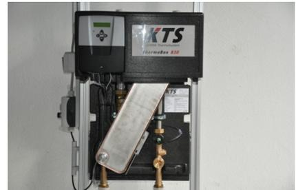
Bild 1 - KTS ThermoBox ohne Verkleidung
