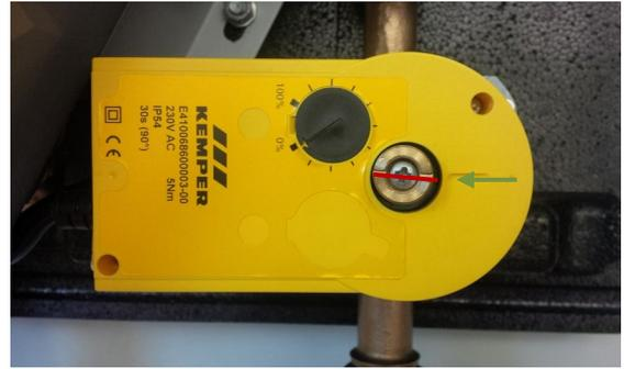
Bild 20 – Stellantrieb im geschlossenen Zustand
