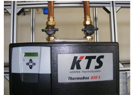
Bild 7 - Absperrung der Heizungsseite
