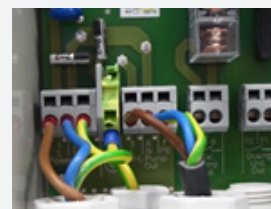
Alimentazione di corrente pompa 5; 6; 7
