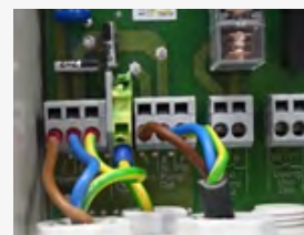
Alimentazione di corrente pompa 5; 6; 7
