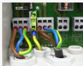
Alimentazione di corrente impianto 1; 2; 3
